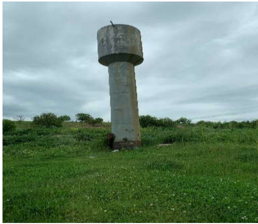
Fotografii 5 -8 Înmagazinarea apei de la Sonda. Castele de Apă ( W=1x27m^3 ) și Rezervoare de apă ( W=1x10m^3 )
