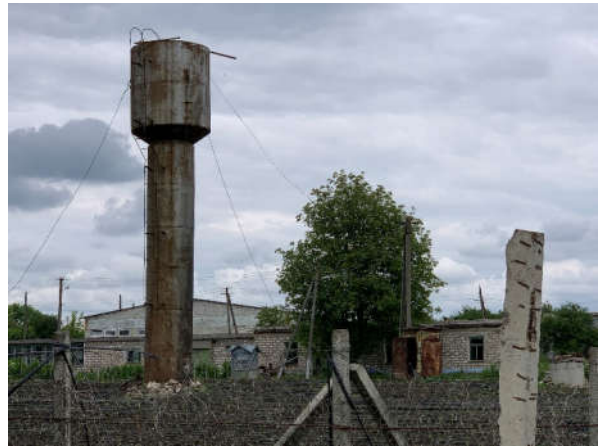
Fotografii 5 -8 Înmagazinarea apei de la Sonda. Castele de Apă ( W=1x27m^3 ) și Rezervoare de apă ( W=1x10m^3 )
