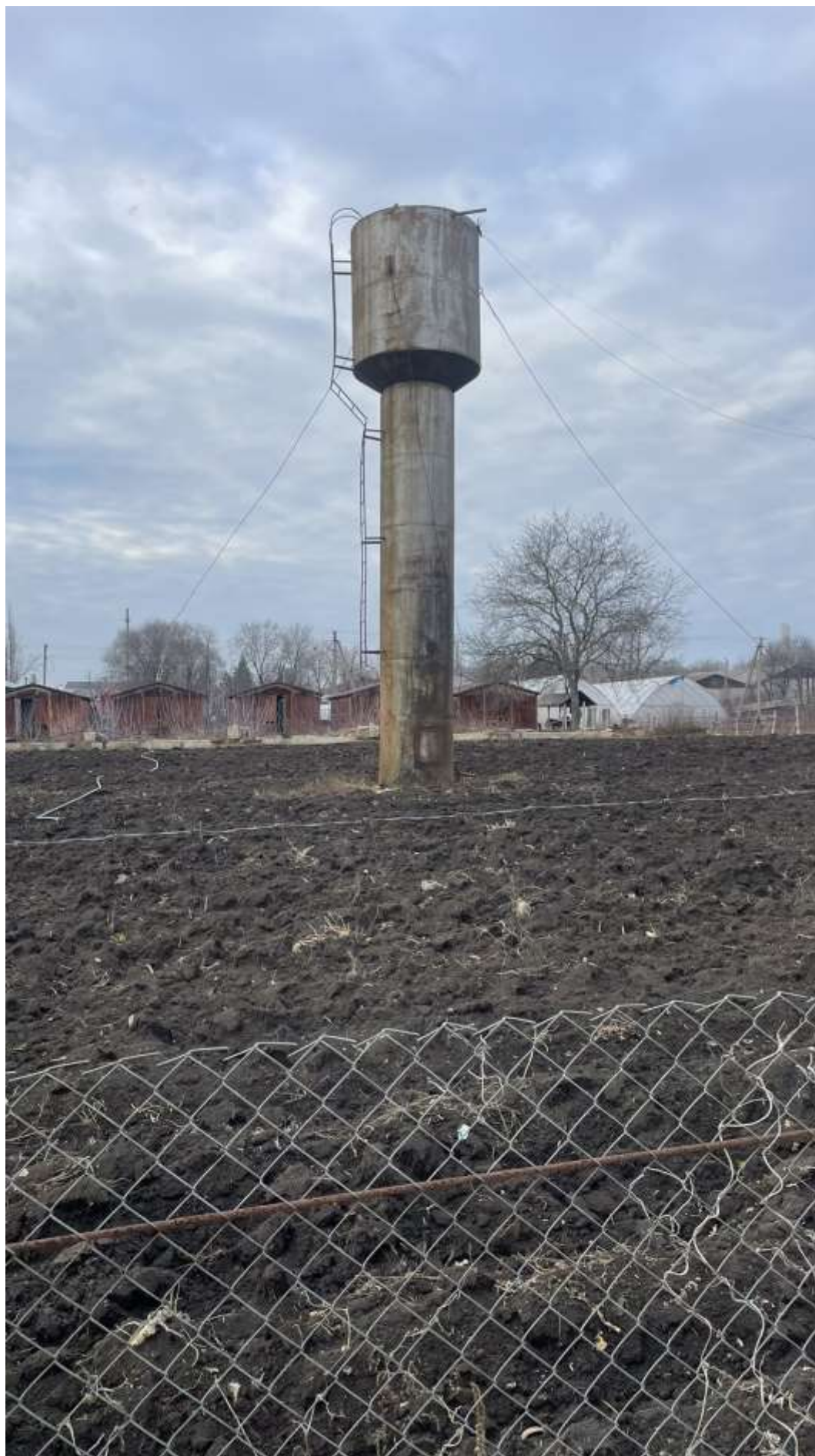
Castelul de apă unde se pompează apa de la sondă (pe același teritoriu cu sonda nr. 3893)
